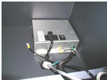
Figura 1. El interruptor de energía se encuentra del lado derecho del módulo de energía.
