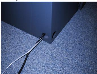
Figura 2a. Cables de energía eléctrica y teléfono guiados a través del agujero de acceso trasero.
