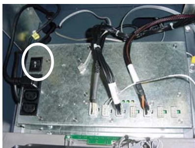
Figura 1. Interruptor sobre el lado izquierdo del módulo fuente de poder
