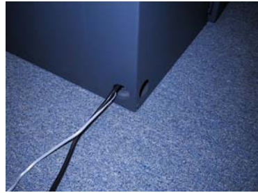
Figura 2a. Energía y cordón de teléfono pasando a través del agujero de acceso posterior.
