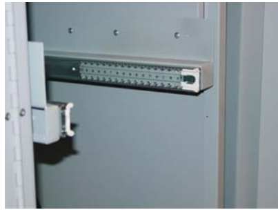
Figura 5. Empuje los carriles en el gabinete antes de la instalación del mecanismo de distribución en el gabinete.
