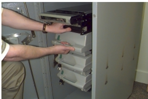
Figure 4-17a. Dépose de la cassette à rejets.
